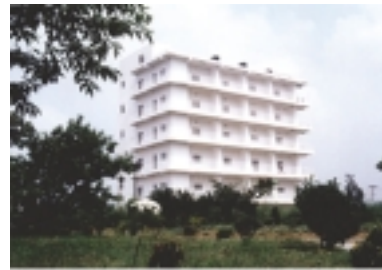
USTC/POLYU Fire Test Atrium
